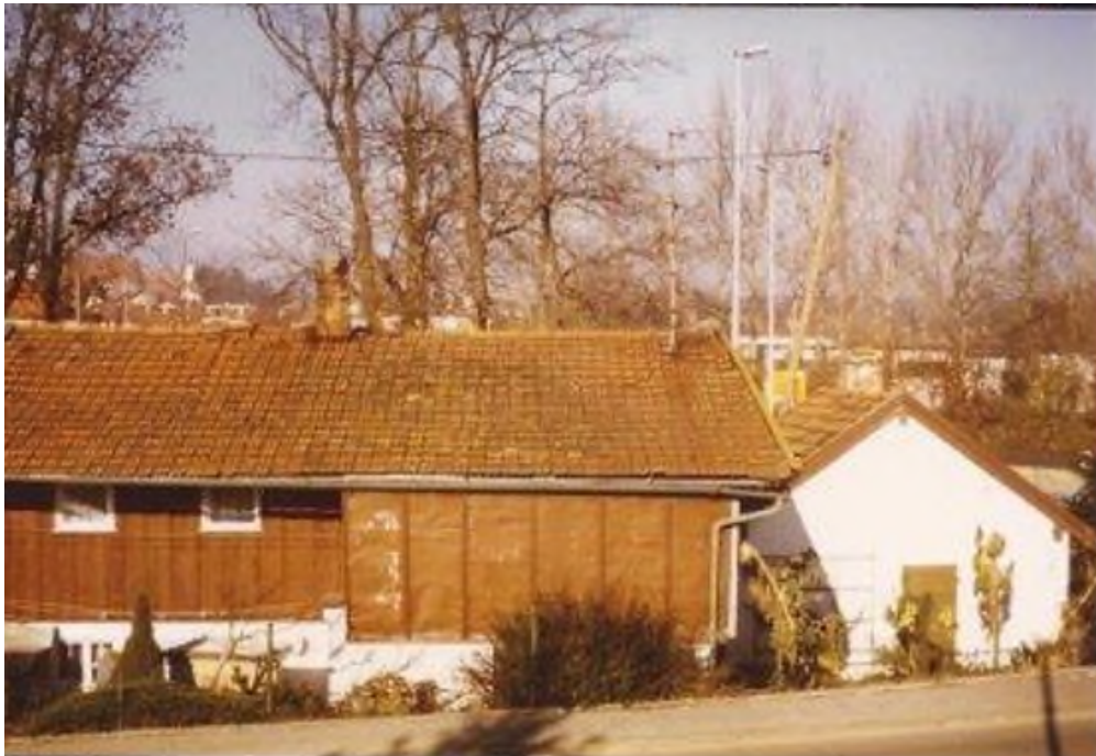
Abbildung 1. Ehemaliges Haus 70b in Bruckhäuser (Ansicht von Süden)
